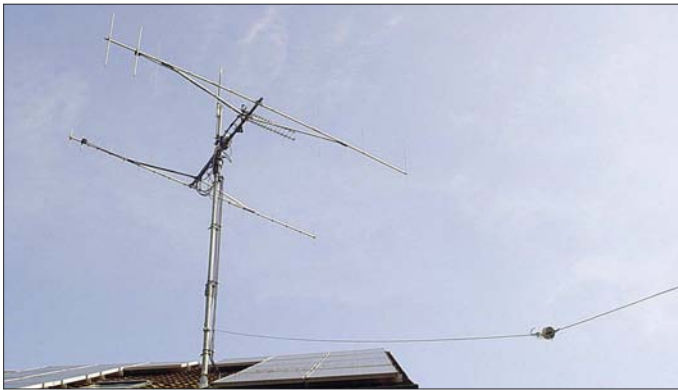
Bild 8: Der Antennenmast auf dem Hausdach dient gleichzeitig zur Abspannung des Breitbanddipols.
