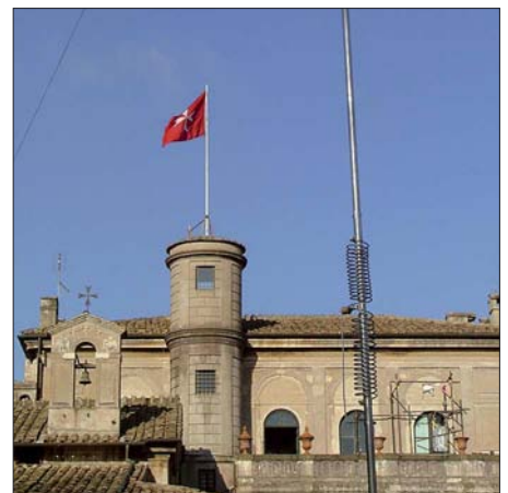
Butternut-Antenne vor einem Ordensgebäude
