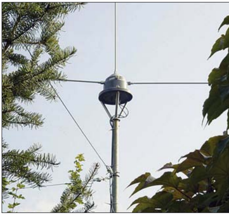
Bild 3: Speisepunkt in Nähe der Aktivantenne
